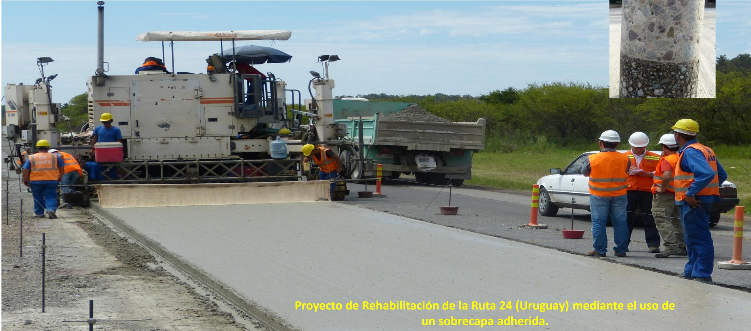
Proyecto de Rehabilitación de la Ruta 24 (Uruguay) mediante el uso de un sobrecapa adherida.
