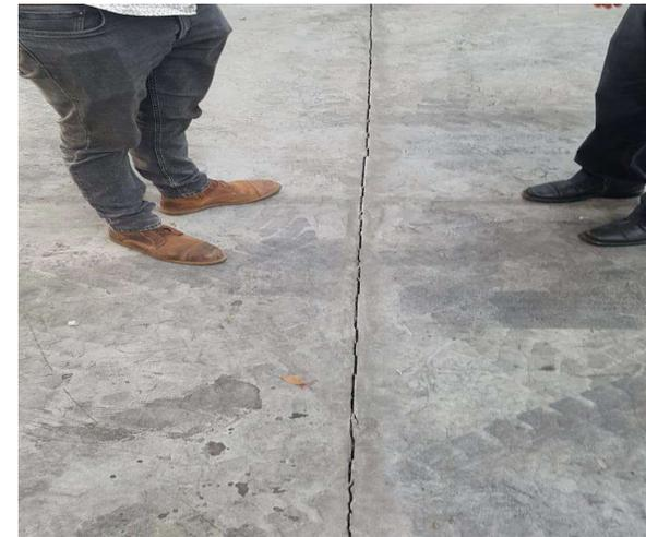
Grietas en pisos generadas por relleno inestable adyacente
