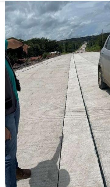
Grieta paralela a la cara externa del muro y adyacente a la losa en el tramo del bastión 1 y junta de la losa desplazada en el eje central de la carretera
