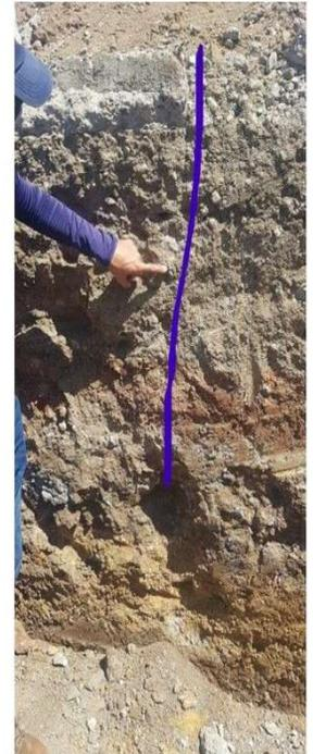
. Detalle de las grietas inyectadas detectadas en el corte. Nótese la profundidad alcanzada
