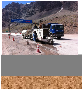
Pavimento de Hormigón Tradicional + Cepillado ½ vida
