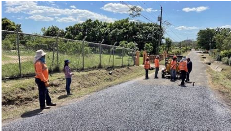
Costa Rica MMEC-Hojancha CR. Mantenimiento de TSB
