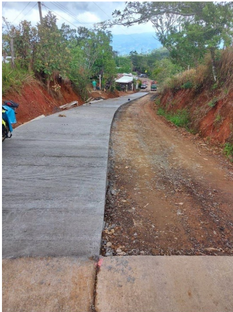
Losa de concreto comunal convenio Municipalidad de Puriscal, Costa Rica
