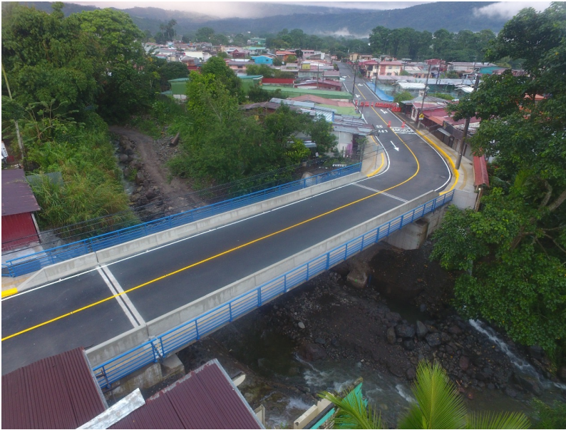
Puente Río Colorado Turrialba Camino-164
