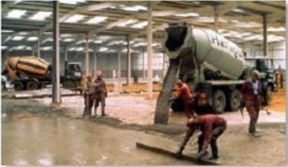
En los años 70 se introdujo el uso de los niveles láser como herramienta de trabajo para la nivelación de los pisos industriales. La autonomía de los equipos de trabajadores para nivelar sus losas fue esencial para la seguridad y la confianza en su acabado. La ejecución seguía siendo muy manual, pero ya no se dependía de aparatos o medios poco fiables para la nivelación. **La ejecución de pisos se realizaba mayoritariamente por franjas** para obtener determinado nivel de planimetría.
