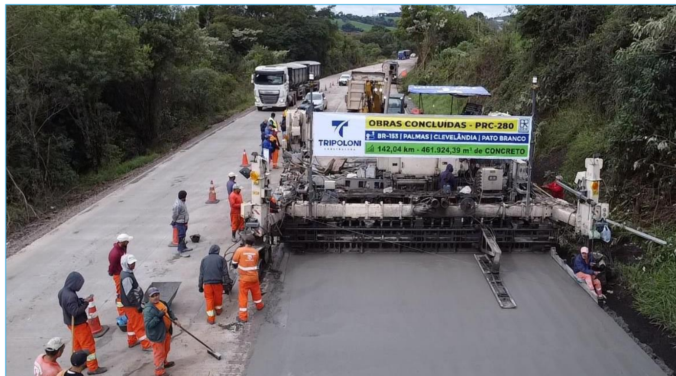
Término da Pavimentação do 3º Trecho da PRC 280 (23_jun_25)
