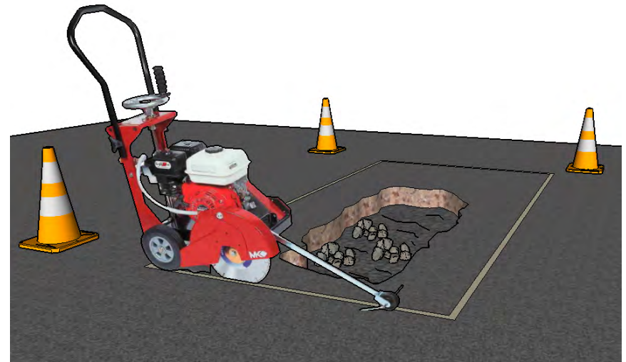
Demarcación y corte de área a reparar
