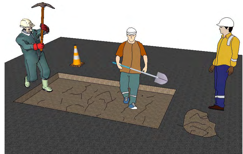
Excavación y retiro de material con equipo manual.
