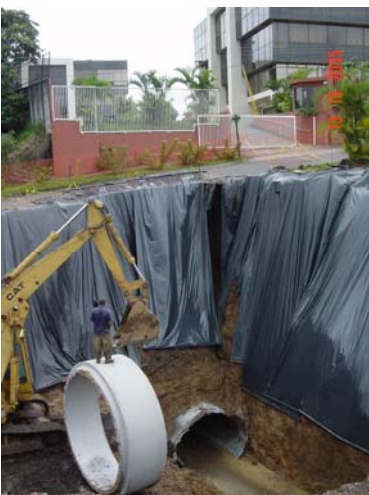
Fotografía 17. Instalación de la tubería
