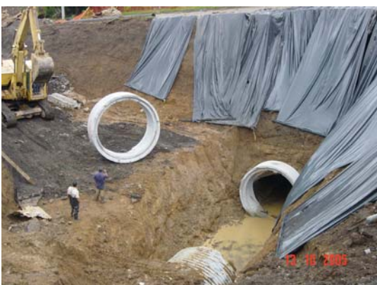
Fotografía 18. Instalación de la tubería
