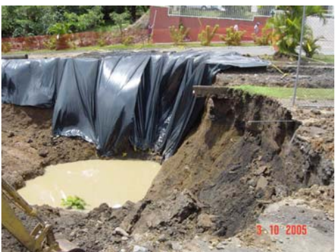
Fotografía 13. Proceso de excavación
