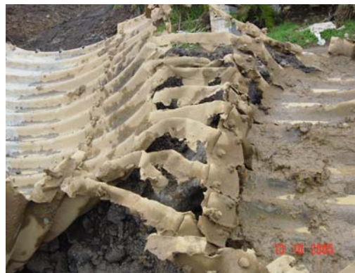
Fotografía 19. Tubería colapsada
