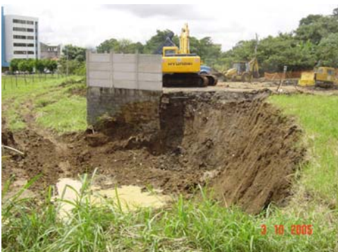
Fotografía 12. Proceso de excavación
