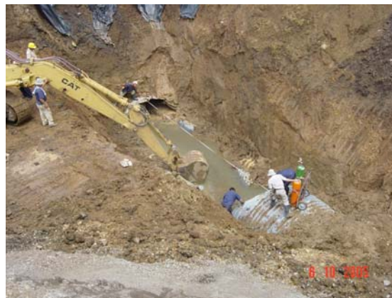
Fotografía 15. Medición del tramo crítico
