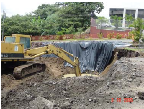
Fotografía 11. Proceso de excavación
