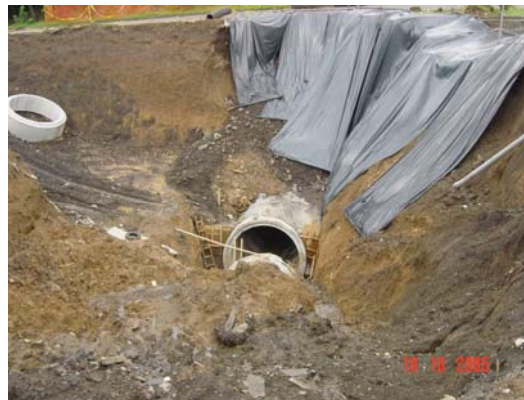
Fotografía 27. Trabajos de reconstrucción
